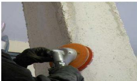
Figure 3-16 : ponçage au disque diamant des différentes faces du poteau et meulage des angles pour les arrondir.
