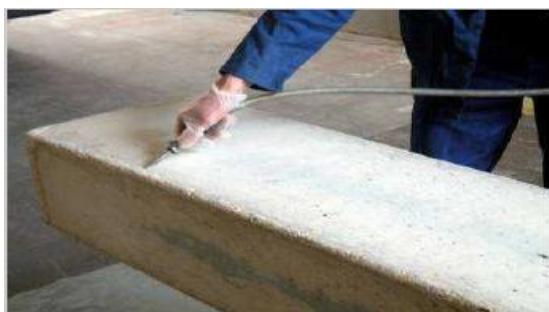
Figure 3-17 : Evacuation des poussières au moyen d'air comprimé.
