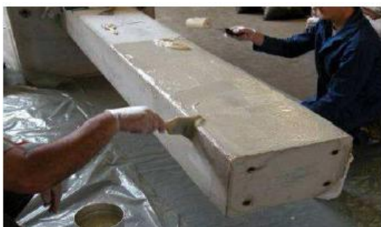
Figure 3-18 : Application d'une couche de résine .
