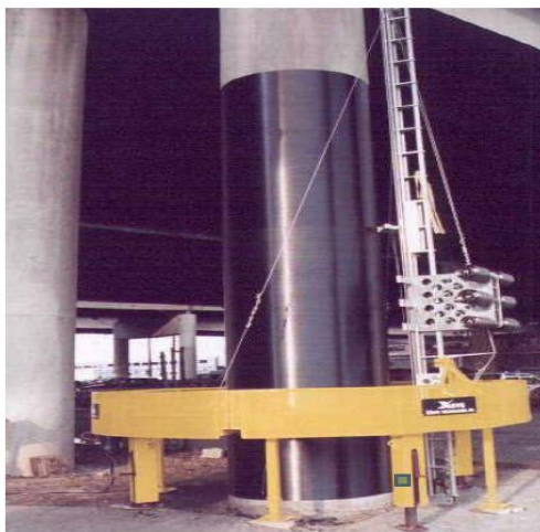
Figure 3-22 : Enroulement filamentaire .
