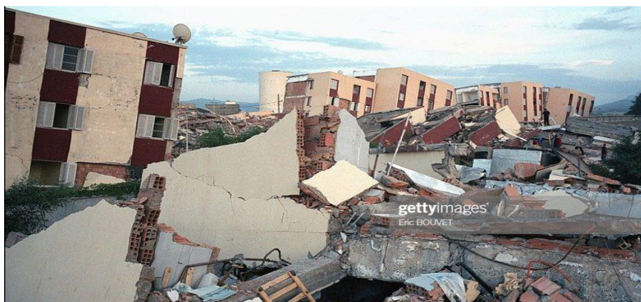
Figure 1-2 : Dommages au tremblement de terre de Boumerdès .
