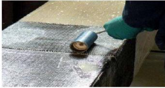
Figure 3-20 : Marouflage au rouleau .
