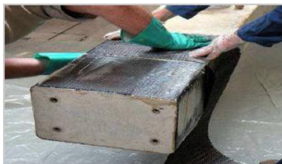
Figure 3-19 : Pose des bandes de PRF .
