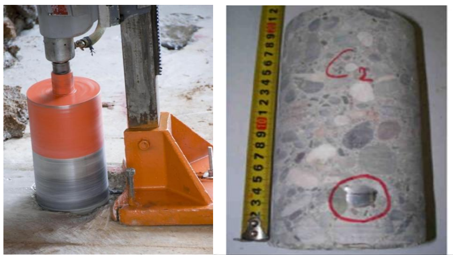
Figure 1-23 : carottage du béton
