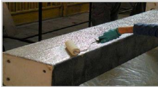
Figure 3-21 : Pose d'une couche de résine de couverture
