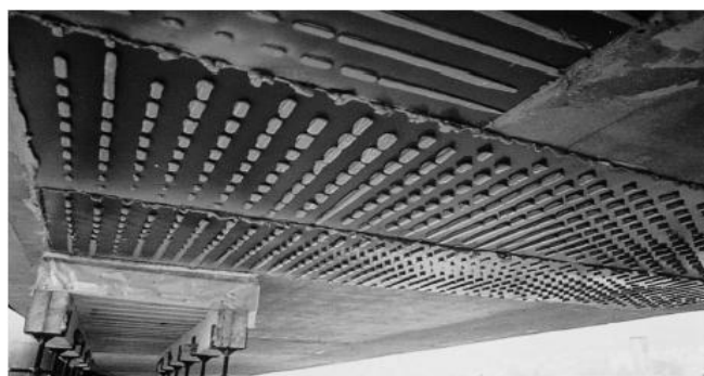
Figure 2-9 : Renforcement du viaduc de Terre noire par tôles collées perforées -Brevet Freyssinet . [22]
