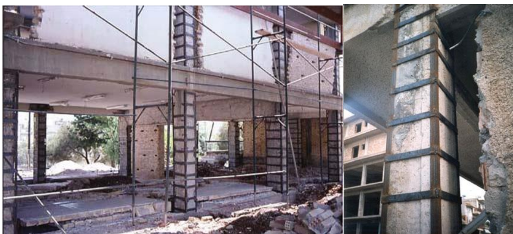
Figure 2-4 : Chemisage en acier appliqué aux poteaux
