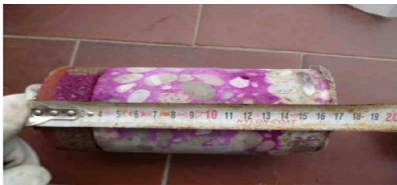
Figure 1-26 : Carbonatation sur carotte
