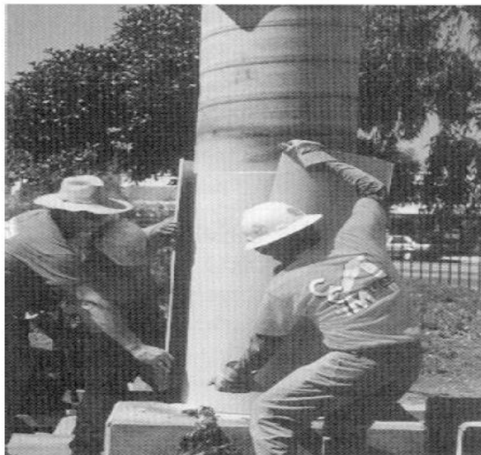
Figure 3-23 : Chemisage par coquille préfabriquée en 'PRF'.
