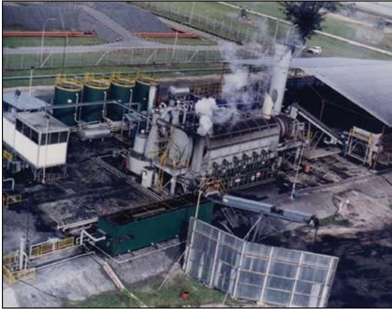
الشكل II. 2: الامتصاص الحراري غير المباشر بالفرن الدوار. (The M-I SWACO، 2008)
