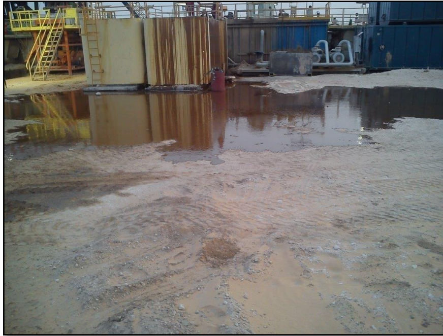
Figure 05 : Pollution par fuite de fluide de forage. (SSRHMD).
