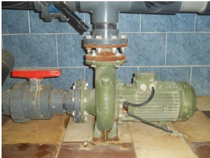
Photo I.2 : Pompe centrifuge axiale
