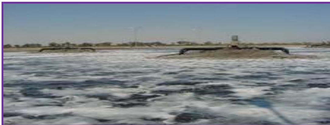
Photo (III.4): Une station d'épuration à Lagunes aérées. (Dhaouadi,2008)
