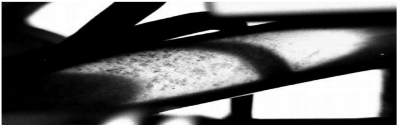
Figure 2: Biofilm présent sur la paroi interne de la tuyauterie d'un piscine
