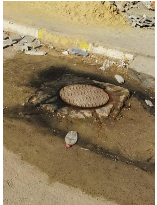
figure (3.1) : regard remplis des déchets et regard qui débord
