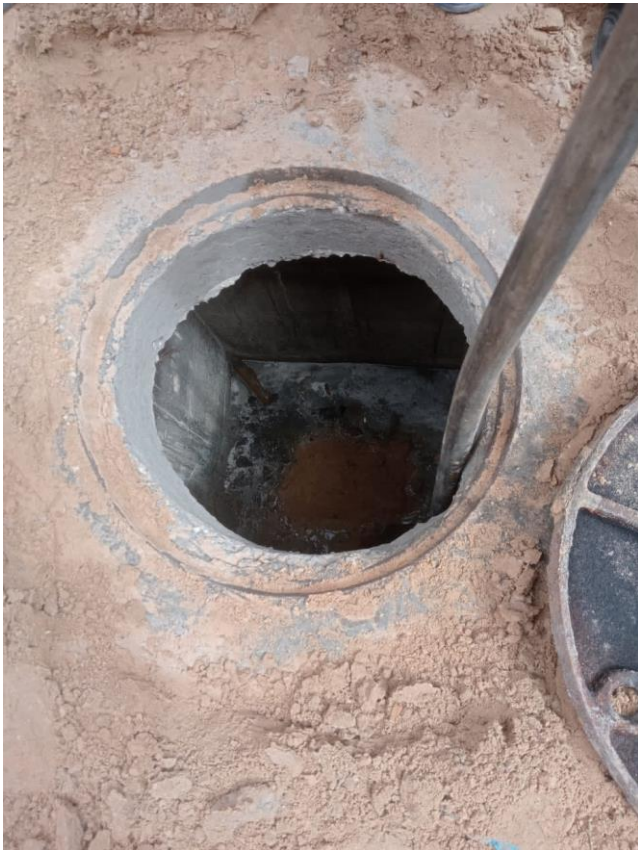
figure (3.1) : regard remplis des déchets et regard qui débord
