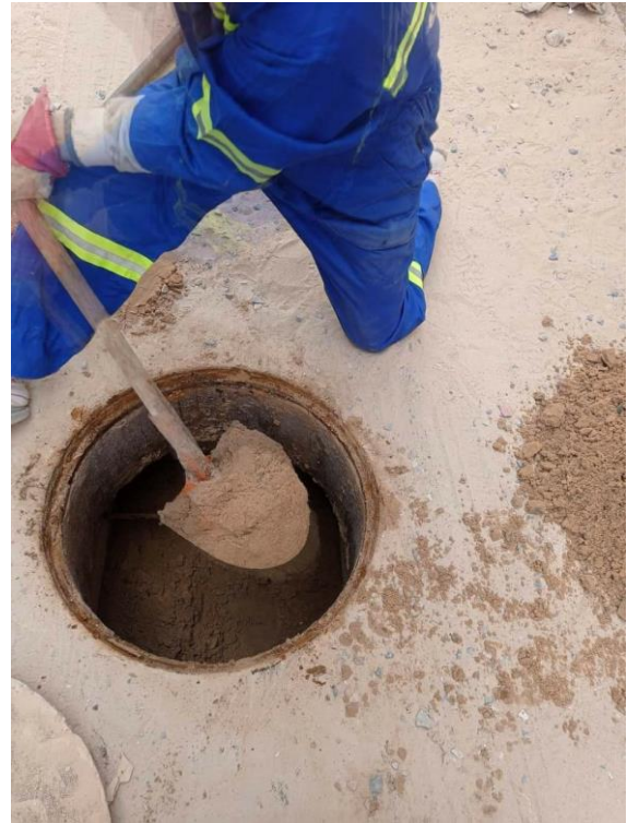
figure (3.2) : regard remplis des déchets
