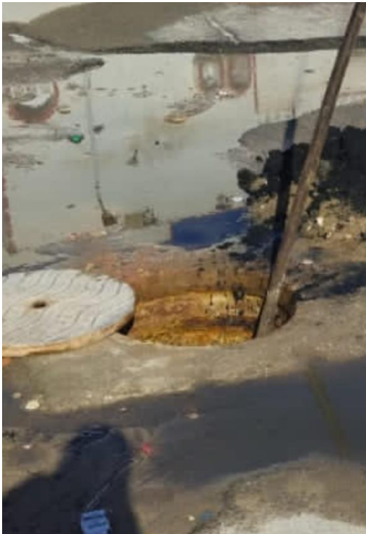
figure (3.2) : regard remplis des déchets
