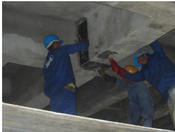
Fig. 4-21:.. Mise en place de la résine
