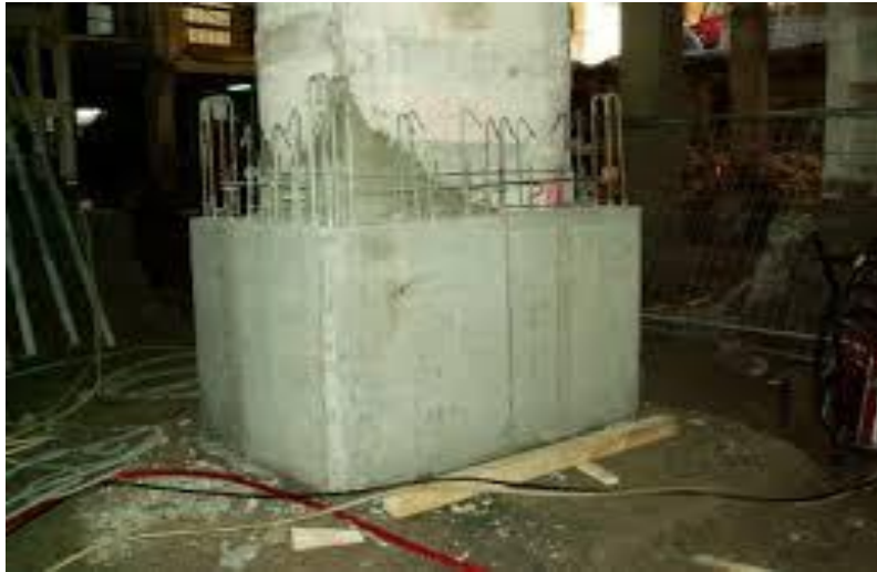
Fig 2.2 : Technique de chemisage
