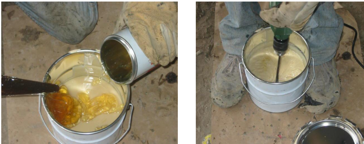
Fig. 4-19 :. Préparation de la colle
