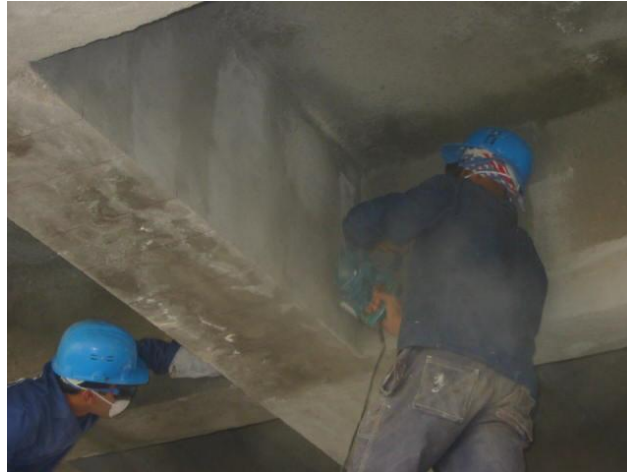
Fig. 4-18 : Ponçage de la surface
