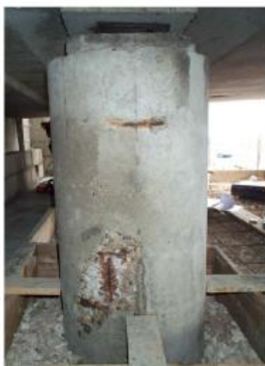
Fig 1-2 : Pile de Pont
