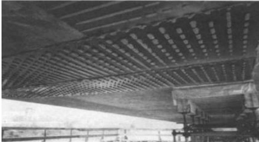
Fig 2-3 : plaques d'acier collées
