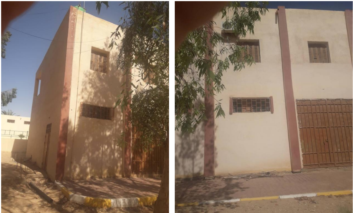
fig 4.6: bloc de maintenance a l'exterieur
