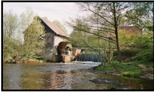
Figure 1.4: moulins à eau
