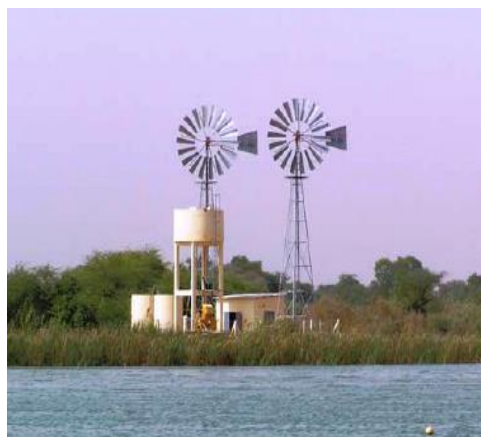
Fig. I-10 : Eoliennes de pompage
