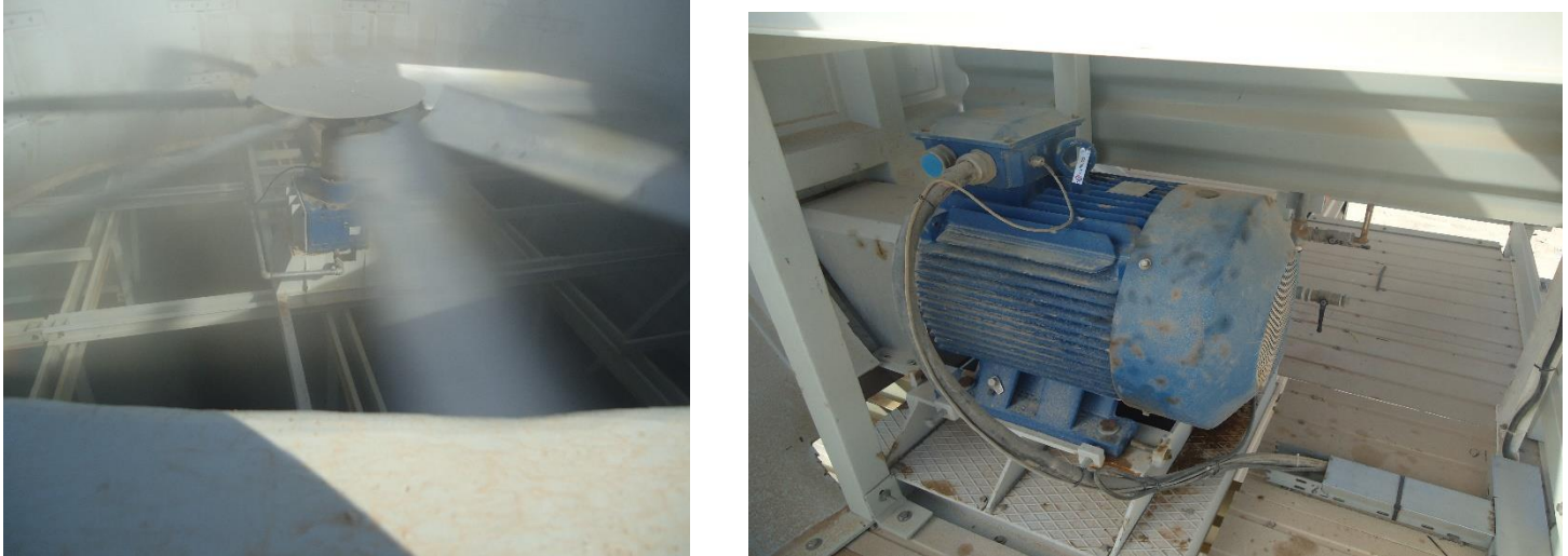
Figure IV. 6: Extracteur d'air chaud du refroidisseur
