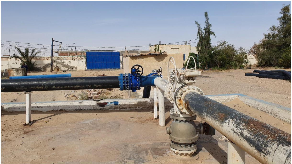
Figure I-10: Exemple de conduite d'adduction
