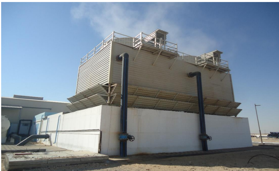
Figure IV. 5: conduite d'amener des eau de forage
