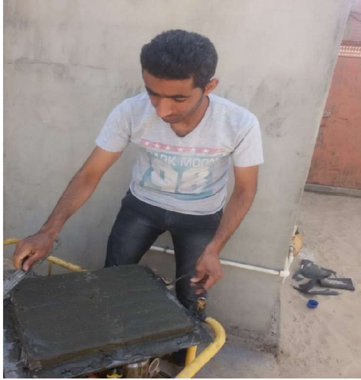
الصورة 3.IV توضح كيفية صب الملاط في القوالب .
