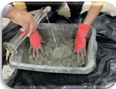
Figure. II.12. Ajouter de l'eau en mélangeant.
