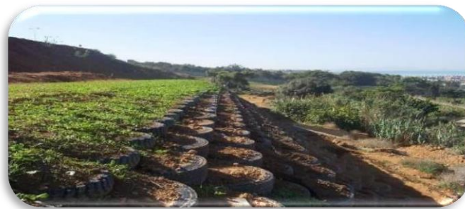
Figure I.11. Ouvrage végétalisé Projet de Bousmail
