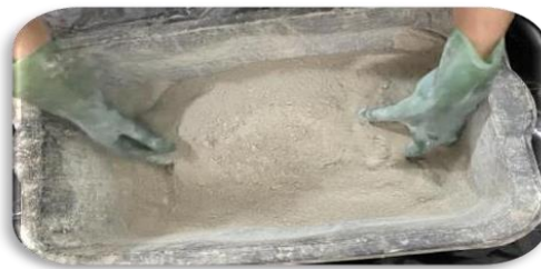
Figure. II.11. Mélanger les matières sèches.
