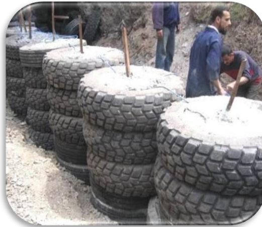
Figure I.12. Bétonnage de la 1ère file de pneus
