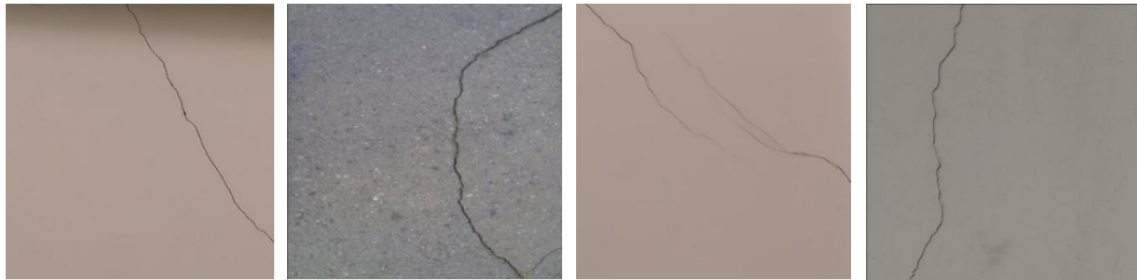
FIGURE IV.3 – Exemple données ajoutées pour la classe "crack" obtenues à partir des panneaux et des murs.
