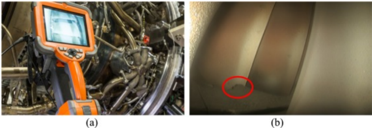
FIGURE III.3 – Exemple de détection de dommages à l'aide d'un borescope en (a) : le borescope en question et en (b) : l'image acquise avec un dommage à la pale.
