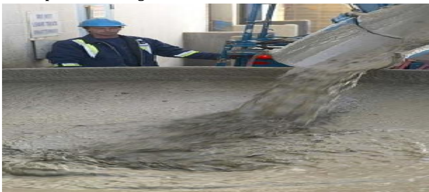
Figure I.5: l'industrie du ciment
