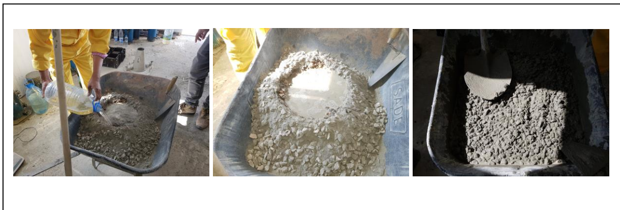
Figure II.31 : Malaxage du béton.
