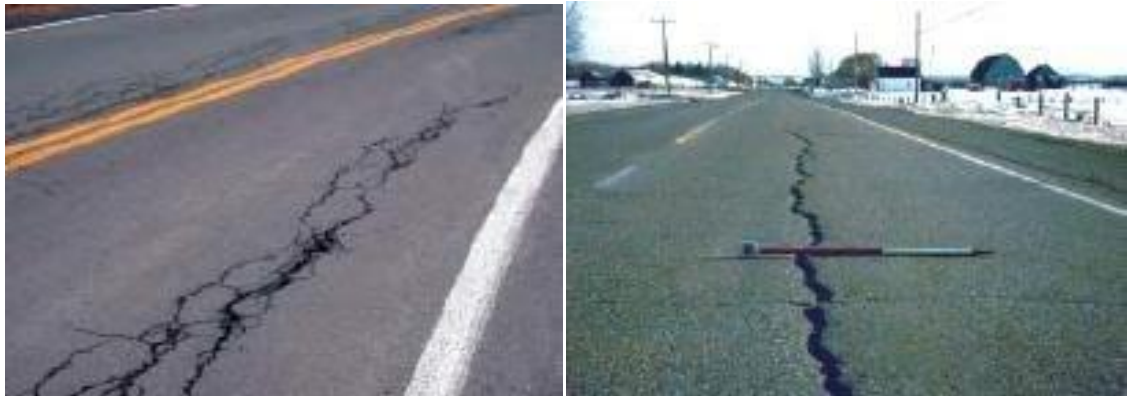
Figure 2.4 : Fissures longitudinales
