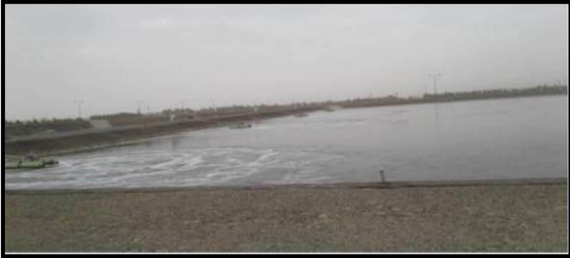
الصورة (4-3): البحيرات المهواة ( المرحلة الثانية B)
