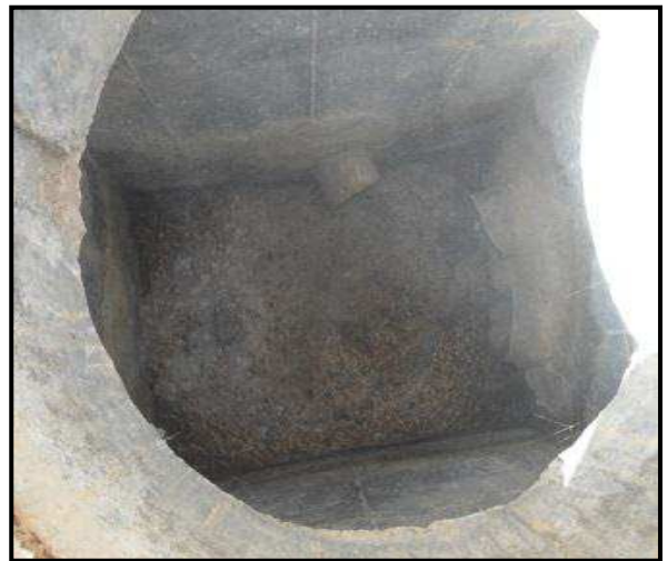
Photo II-1 type des regards à branchement non réguliers
