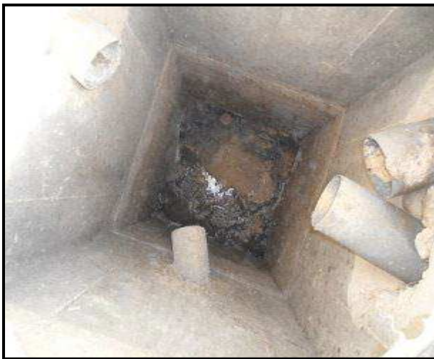
Photo II-1 type des regards à branchement non réguliers
