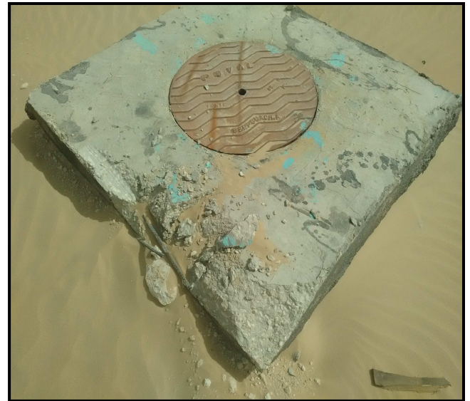
Photo II-4 type des regards a Ferrailage désastreux
