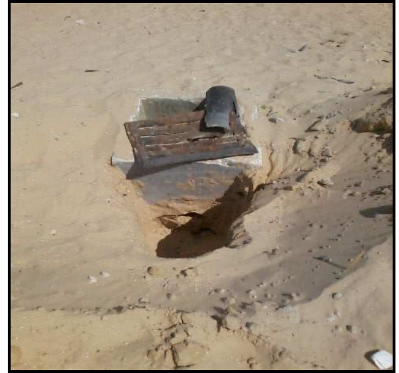
Photo II-3 type des regards et boîte de branchement n'est pas en service
