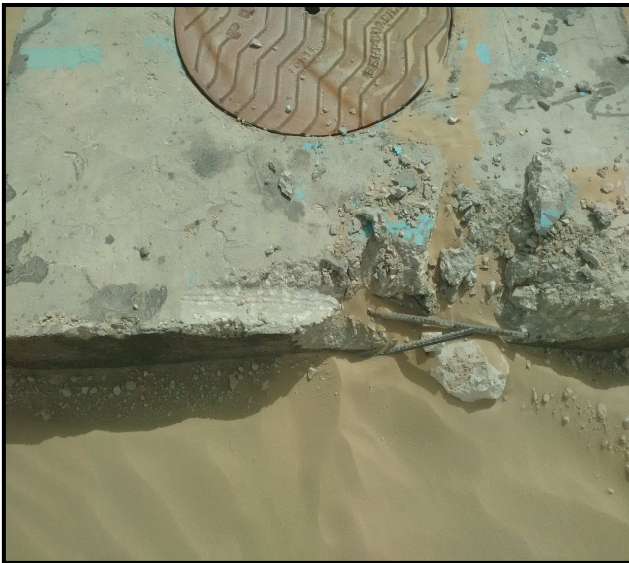
Photo II-4 type des regards a Ferrailage désastreux
