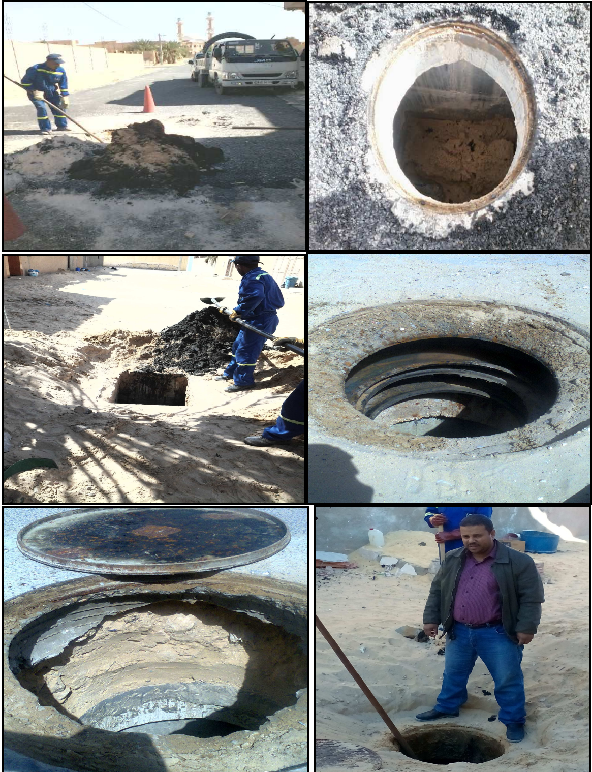
Photo II-11: les Interventions faites dans le Réseau d'assainissement
