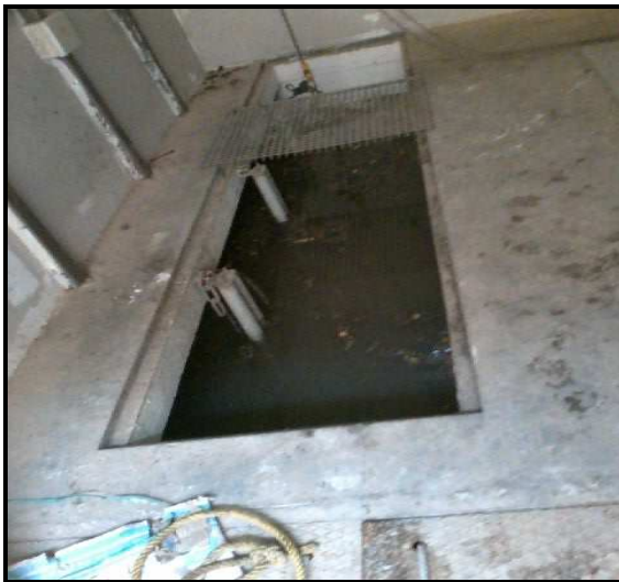
Photo II-10: La bête de Station de refoulement est pleine par l'averse et problème de pompage
