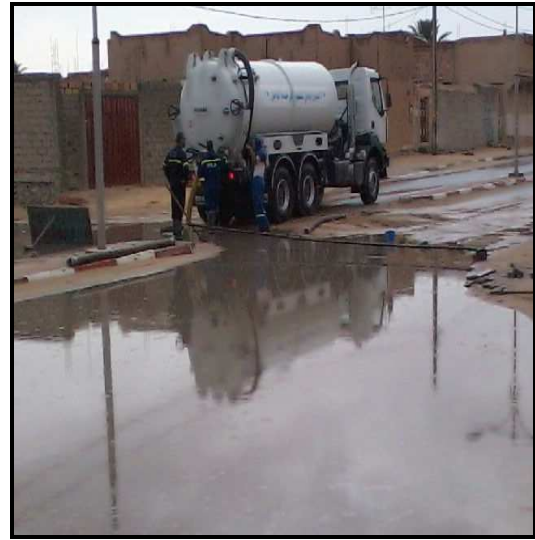
Photo II-09: Manque des Avaloirs des eaux Pluviales
