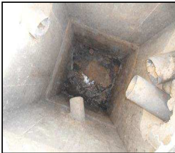
Photo II-6 : type des regards chargés du sable
