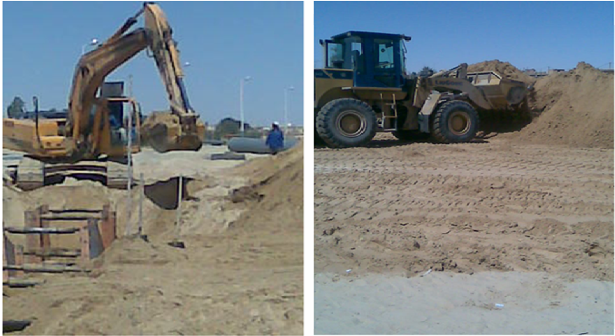
Photo VIII -2 : Terrassement des tranchées.
