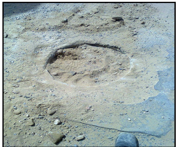
Photo II-6 : type des regards chargés du sable
