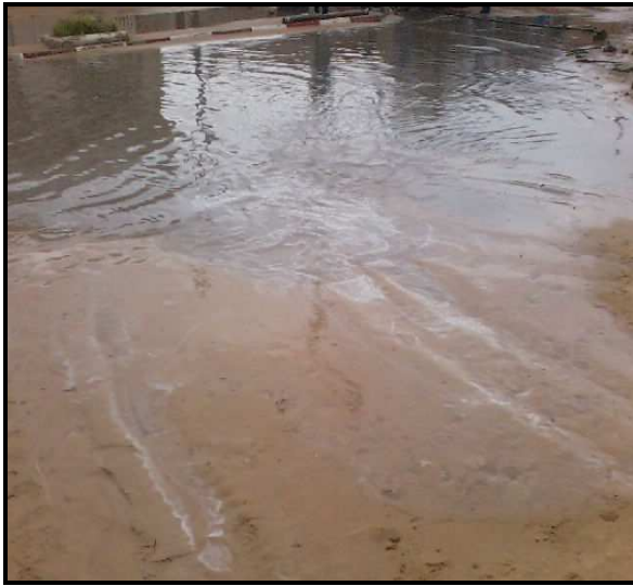
Photo II-09: Manque des Avaloirs des eaux Pluviales
