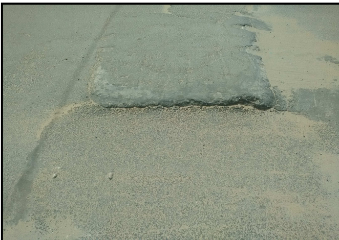
Photo II-2 type des regards mal réalisés
