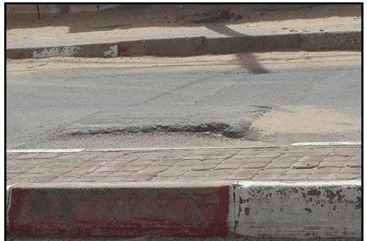
Photo II-2 type des regards mal réalisés
