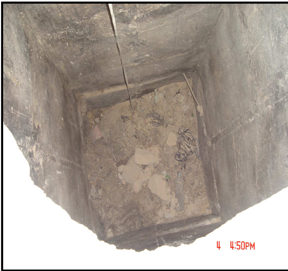
Photo II-3 type des regards et boîte de branchement n'est pas en service
