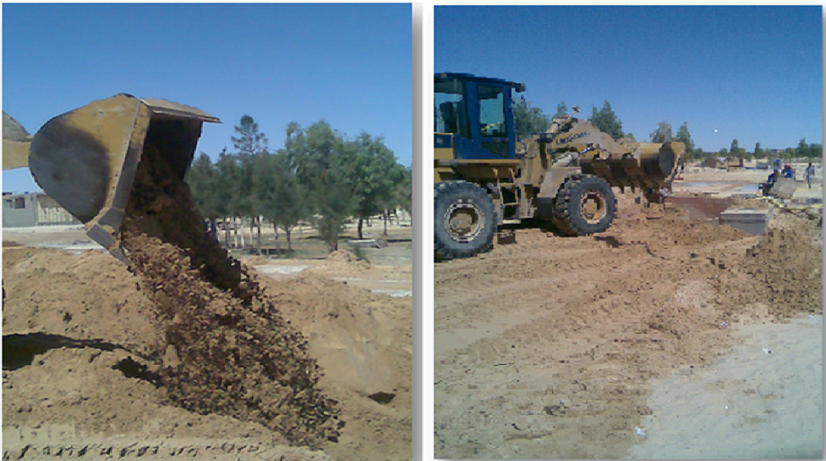
Photo VIII -3 : Remblaiement des tranchées.
