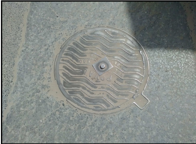
Photo II-5 : type des regards avec des ouvertures fermées
