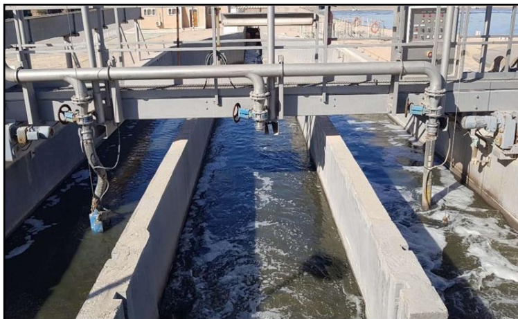
Figure IV.13: les deux pompes d'aspiration sont en panne.
