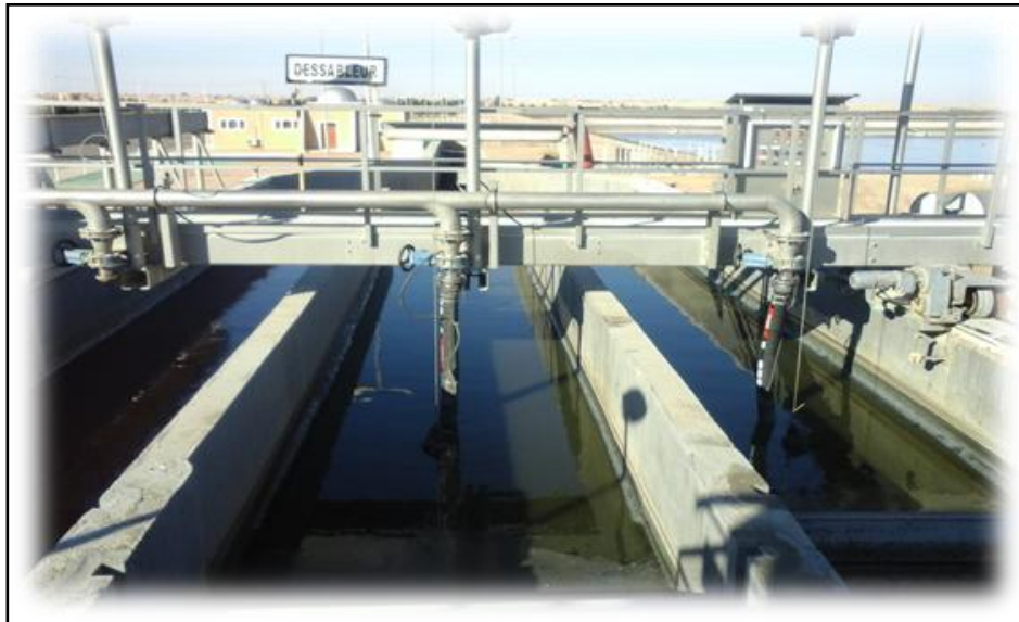
Figure N° III. 09: Dessablage.
