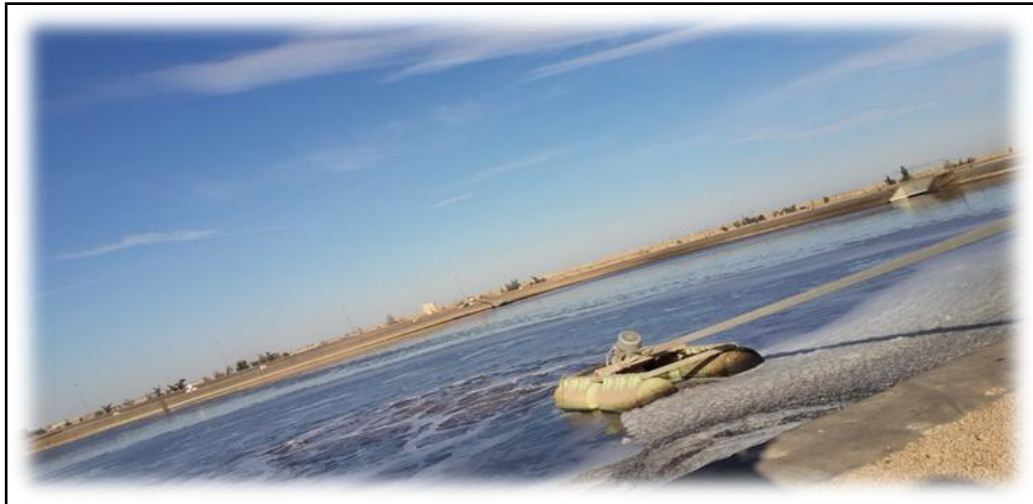
Figure N° III. 12: Aérateur.
