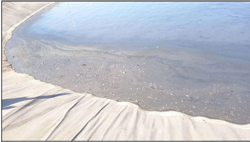
Figure IV.14: présence des débris dans le premier bassin
