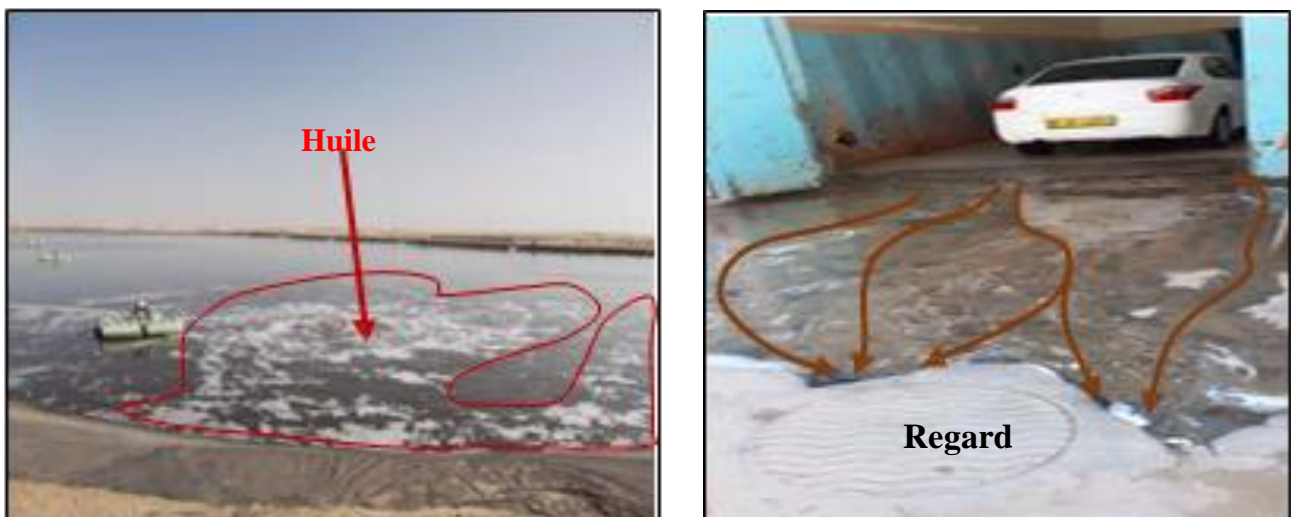
Figure IV.11: Couche des Huiles dans les bassins de lagune et Rejet de lavage vers le réseau d'assainissement.
