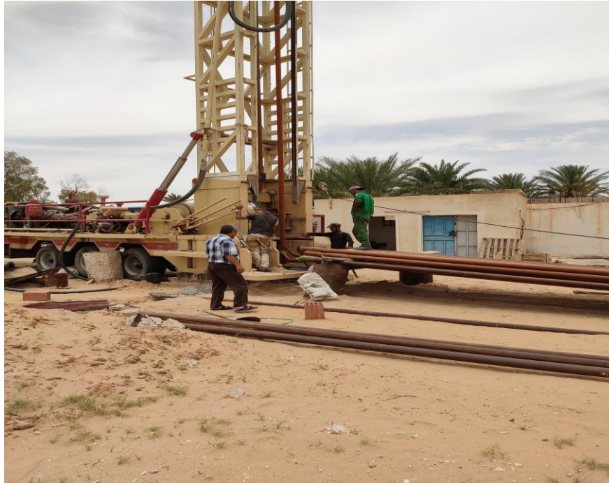
Figure 41 : L'appareil forage lors des travaux de réhabilitation
