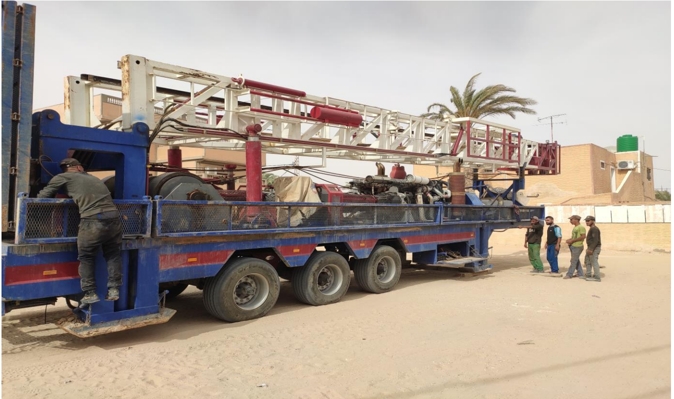
Figure 34 : Machine de forage au chantier (Forage Taghzout Nord)
