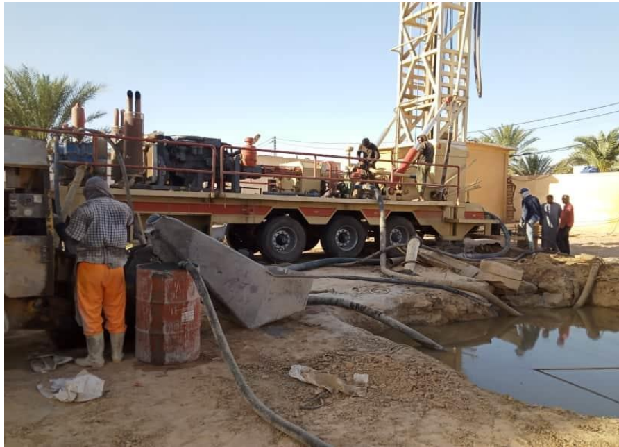
Figure 42 : L'appareil forage lors des travaux de réhabilitation
