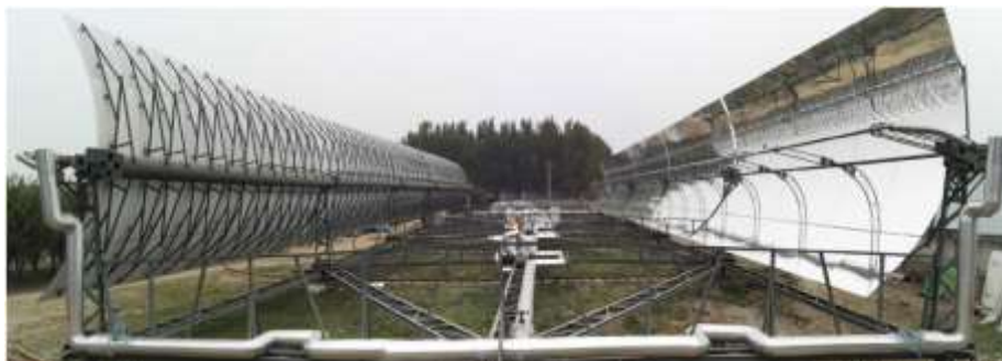
Figure I. 10 : Photo du collecteur solaire cylindro-parabolique de 300 kW avec un axe rotatif [47].
