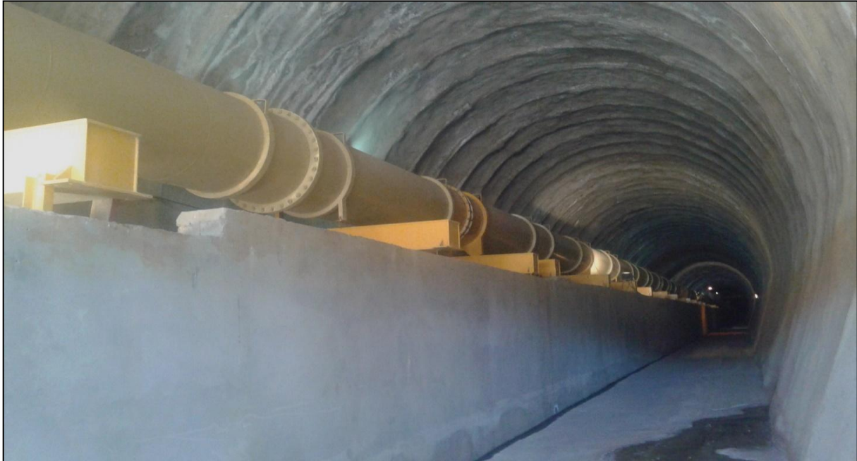
Fig n° II.4 : Tunnel de la vidange de fond
