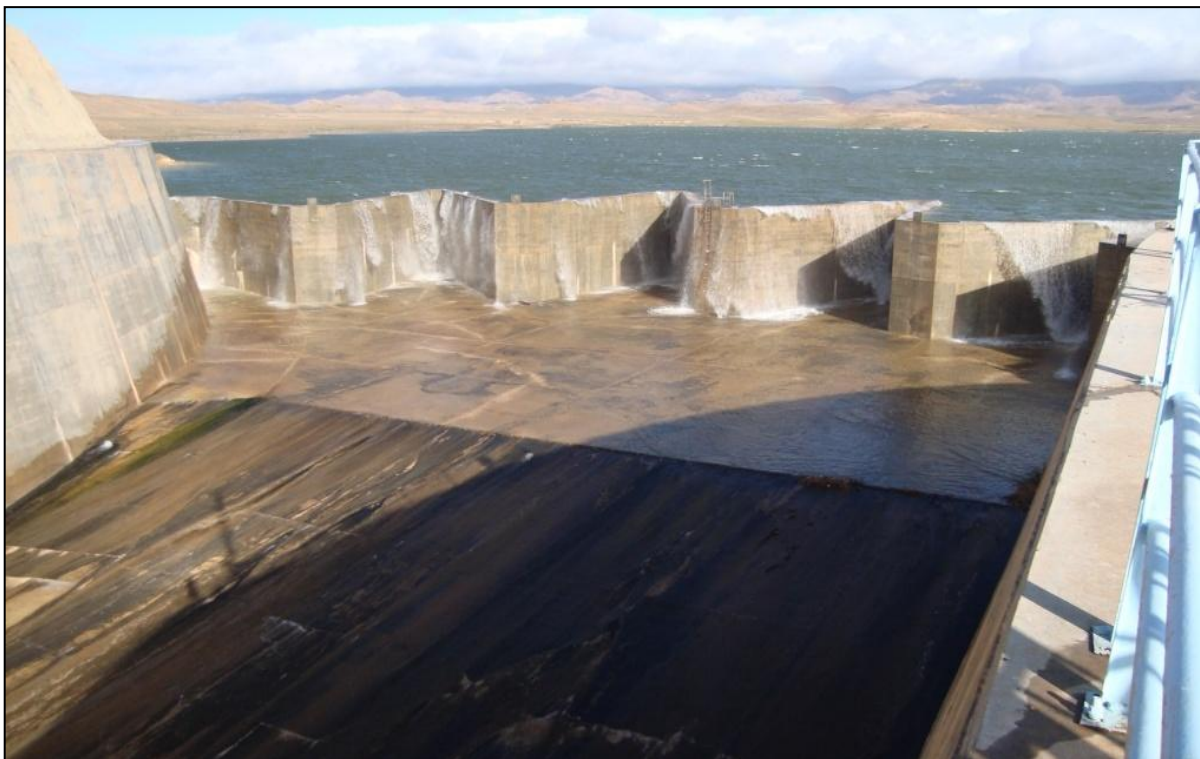
Fig n° II.3 : L'évacuateur de crue (ANBT, 2004)
