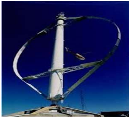
Figure (I.4) : Eolienne à rotor Darrieus.
