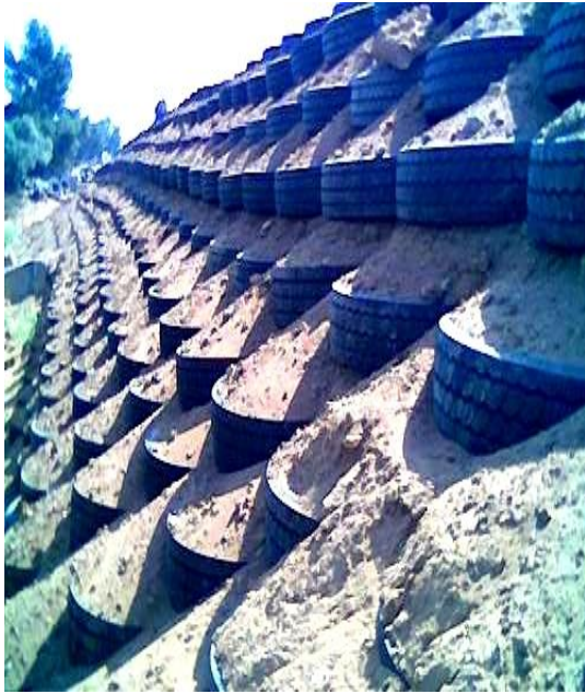
Figure I.9. Pose de nappe de pneus projet pilote bousmail.projet
