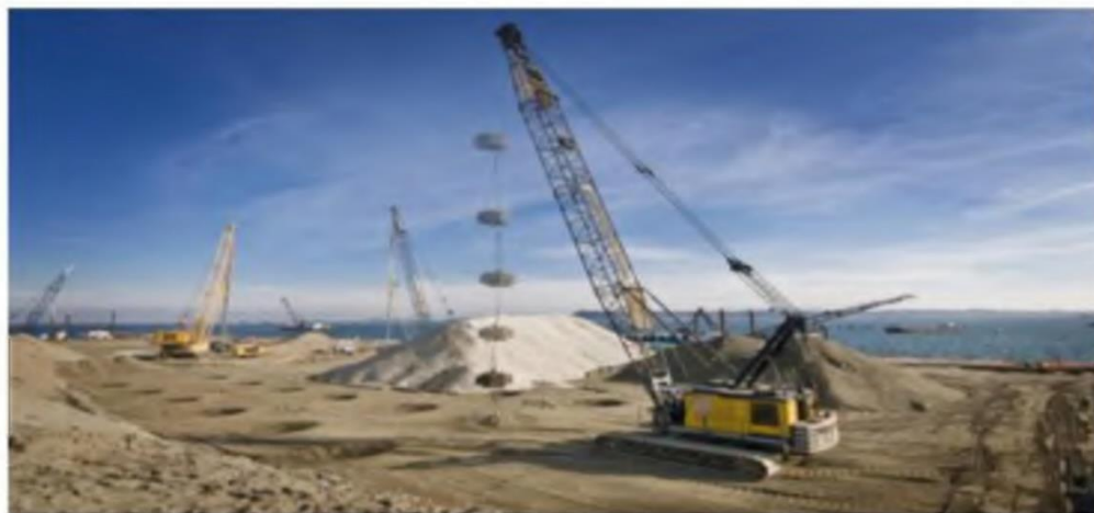
Figure 1.20. Chantier d'un compactage dynamique profond.
