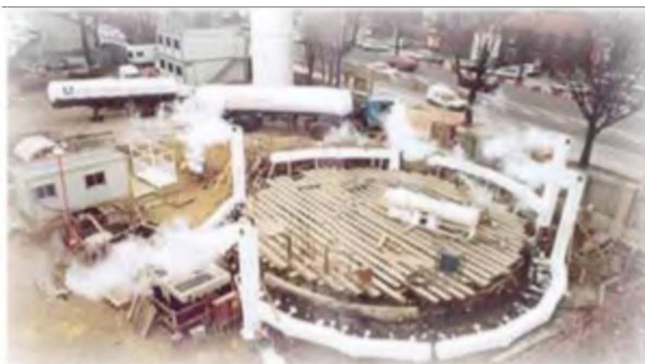
Figure 1.24. Chantier utilisant la congélation du sol.
