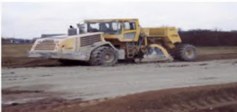
Figure 1.26. Chantier de traitement du sol au ciment.
