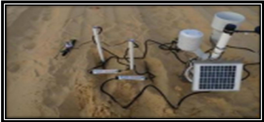
Figure N°18 : Système de surveillance de l'humidité du sol
