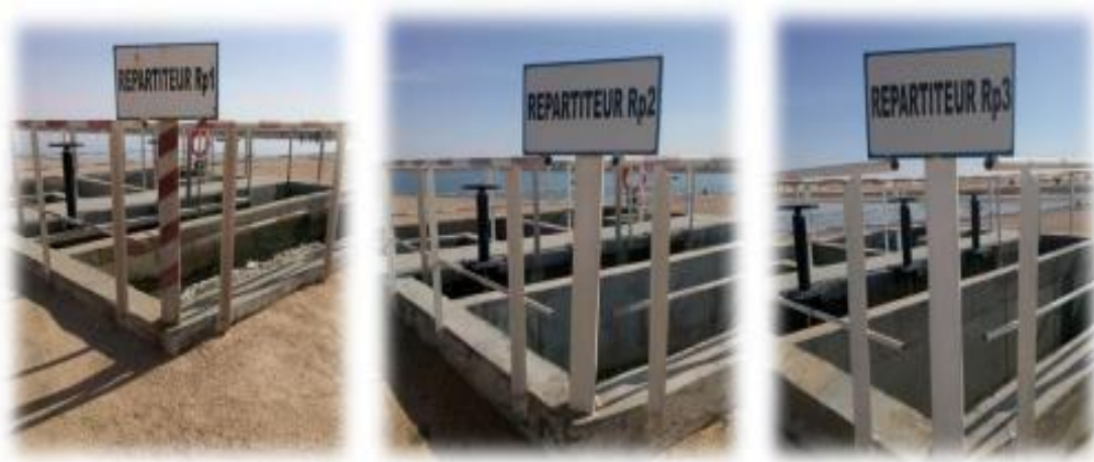
Photo 4 : Répartiteur dans bassins d'aération
