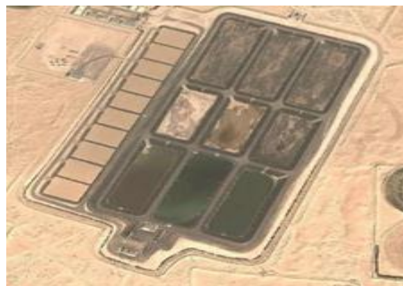
Figure 09 : station de lagunage aéré de Hassani Abdel Karim.
