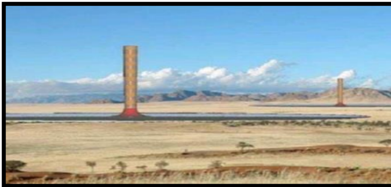
الشكل (1-24) صورة تبين المدخن الشمسية الناميبيية
