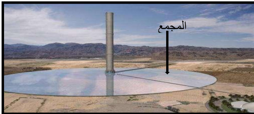
الشكل (2-1): صورة توضح المجمع في المدخنة الشمسية
