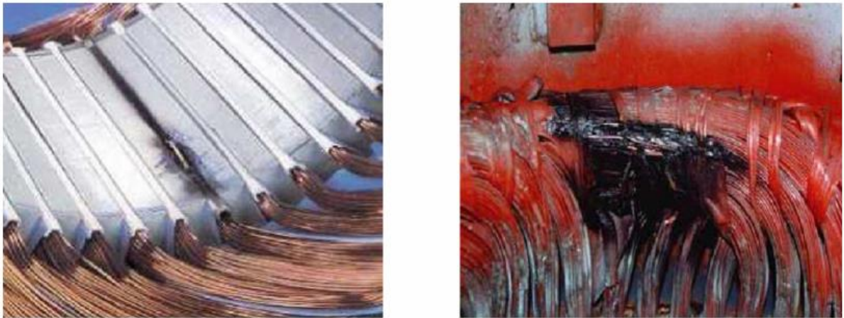
Figure I.4 : Exemples de dégâts dus au défaut de court-circuit statorique d'un moteur asynchrone
