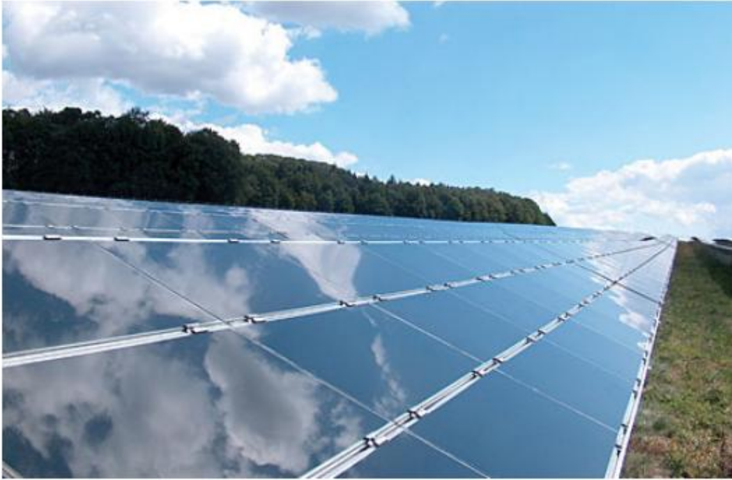
Figure I.16: Modules verre-verre au Telluride de Cadmium, efficacité de 9 à 11%. [14]
