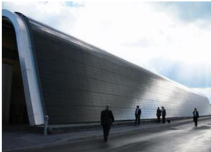
Figure I.17: Façade en CIGS au Pays de Galles, efficacité de 8,5%. [14]
