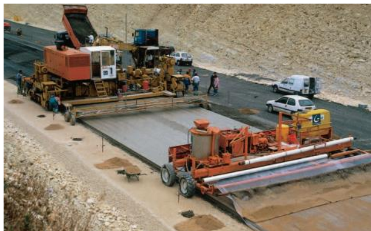
Figure I.14. Voirie en béton de sable. [40]
