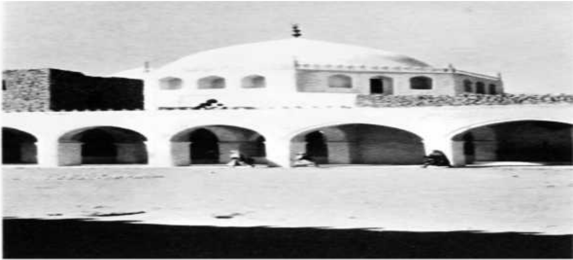
صورة توضح مسجد الجغبوب من الخارج
