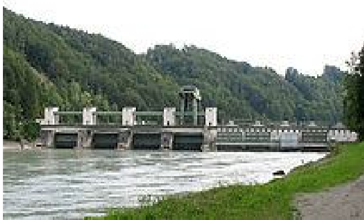
Figure (I.1): Centrale hydroélectrique en Allemagne.
