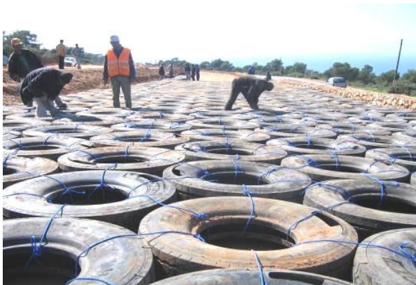
Figure I.13. Ouvrage de Mostaganem RN11 (Algérie)-Stabilité d'un talus
