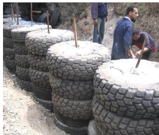
Figure I.15. Bétonnage de la 1ère file de pneus
