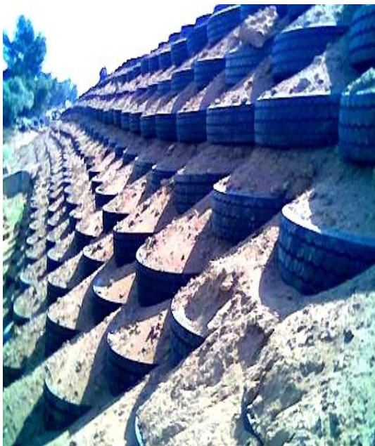
Figure I.10. Pose des nappes de pneus
