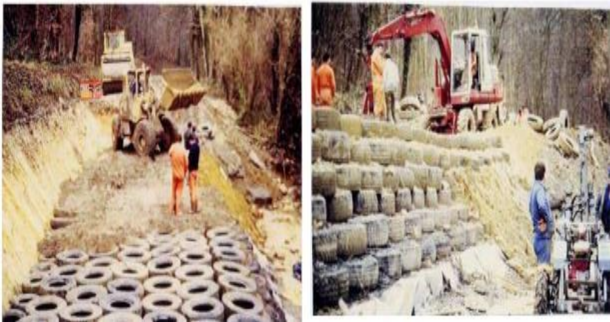
Figure I.9. La technique de Pneu sol : le chantier Cannes-Mandelieu en 1988.
