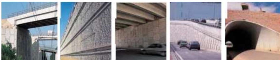
Figure I-25. Quelques ouvrages routiers dans le monde
