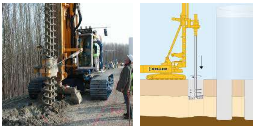
Figure I-13. Le Deep Soil Mixing par voie humide
