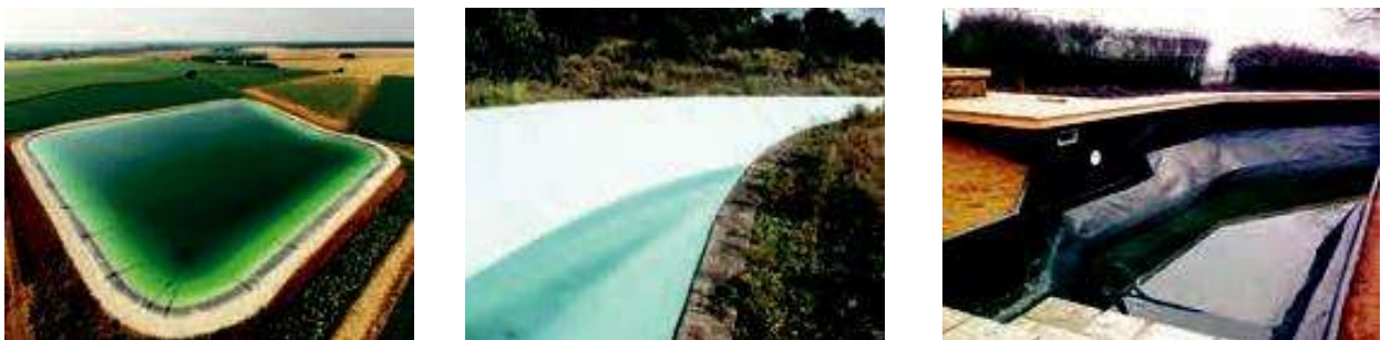
Figure II-12. Quelques exemples d'ouvrages hydrauliques étanchés par géosynthétiques
