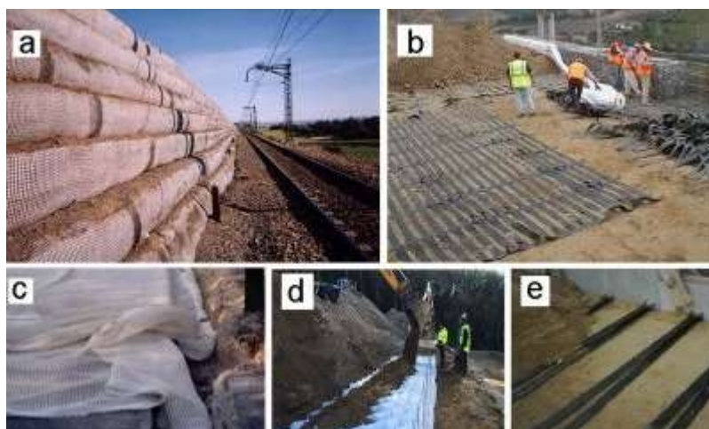
Figure I-2. renforcement des massifs de soutènement a mur
