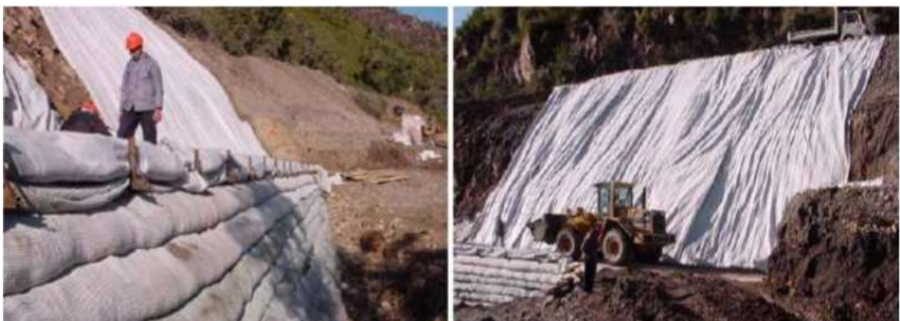
Figure II-39– Construction de l'ouvrage par couches
