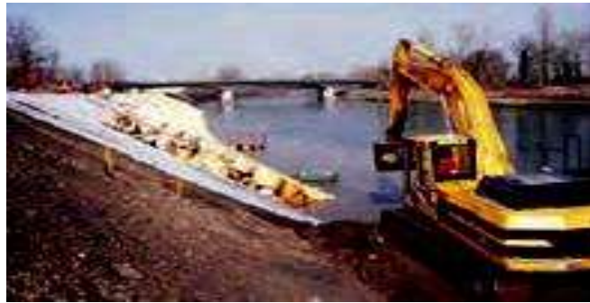
Figure II-14. Géotextile de filtration sous enrochement
