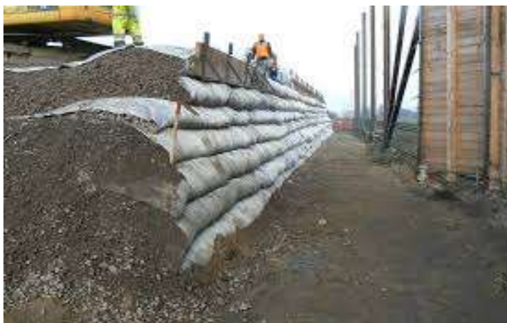
Figure I-24. Instalation de mur renforce par une géogrille
