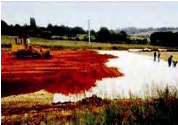
Figure II-30. Mise en œuvre du remblai sur le géocomposite de drainage
