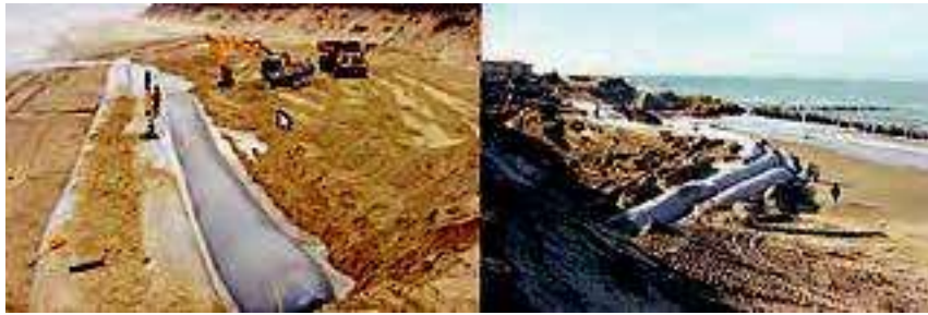
Figure II-15. Schéma d'aménagement simple pour limiter l'érosion d'un terrain par tubes géosynthétiques
