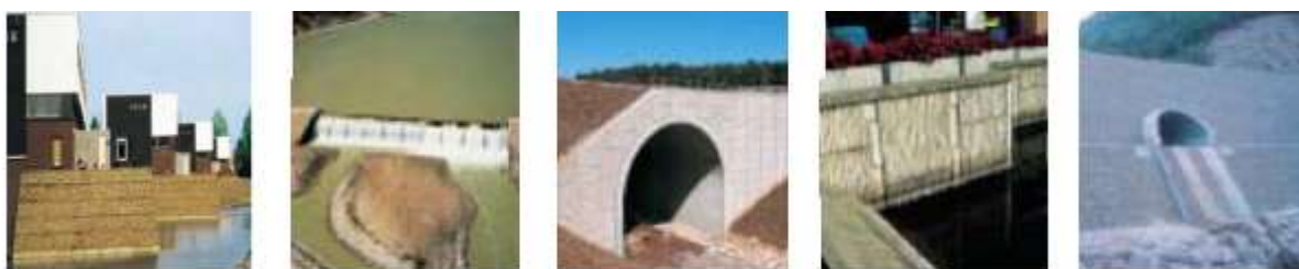
Figure I-28. Quelques ouvrages hydrauliques dans le monde
