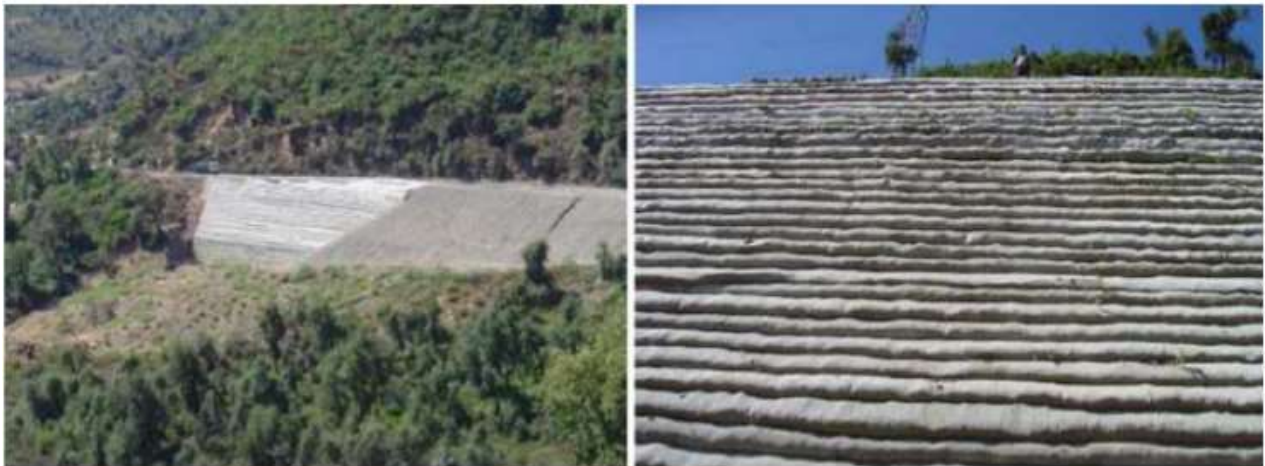
Figure II-41- Vue de l'ouvrage achevé.
