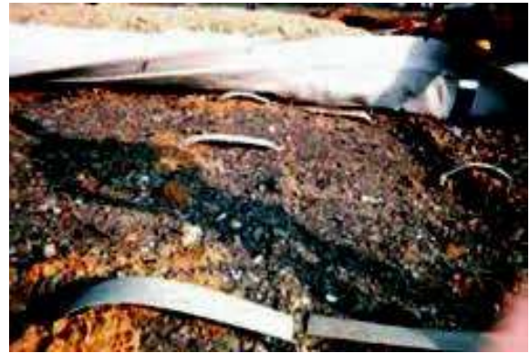
Figure II-31. Pose du géocomposite de drainage au contact des drains verticaux
