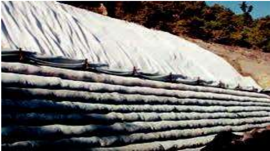
Figure II-48. Profil type de position du géocomposite de drainage en talus renforcé
