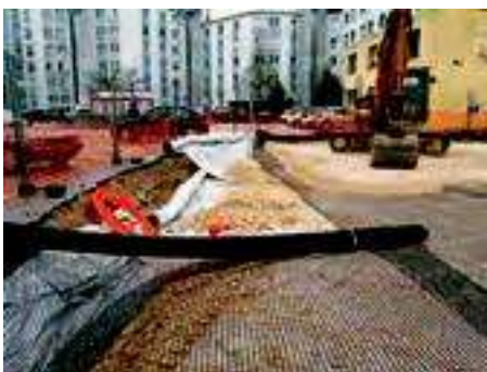
Figure II-21. Utilisation d'une géogrille en renforcement de couche de forme
