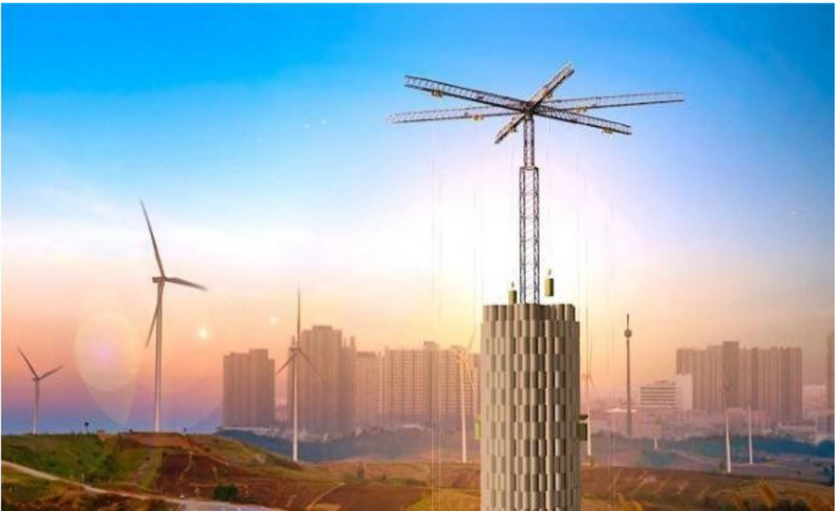
Figure 08: Mise en contexte du système dans un parc éolien. Les blocs de béton utilisés sont issus de la récupération de déchets de construction. Crédits : Energy Vault.
