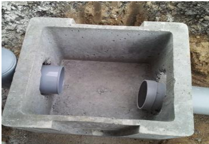
Figure V.4. Regard de chute
