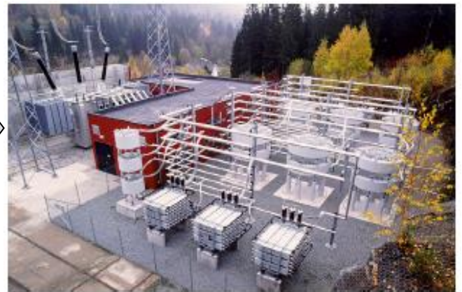
Figure II.2 SVC installée dans le réseau
