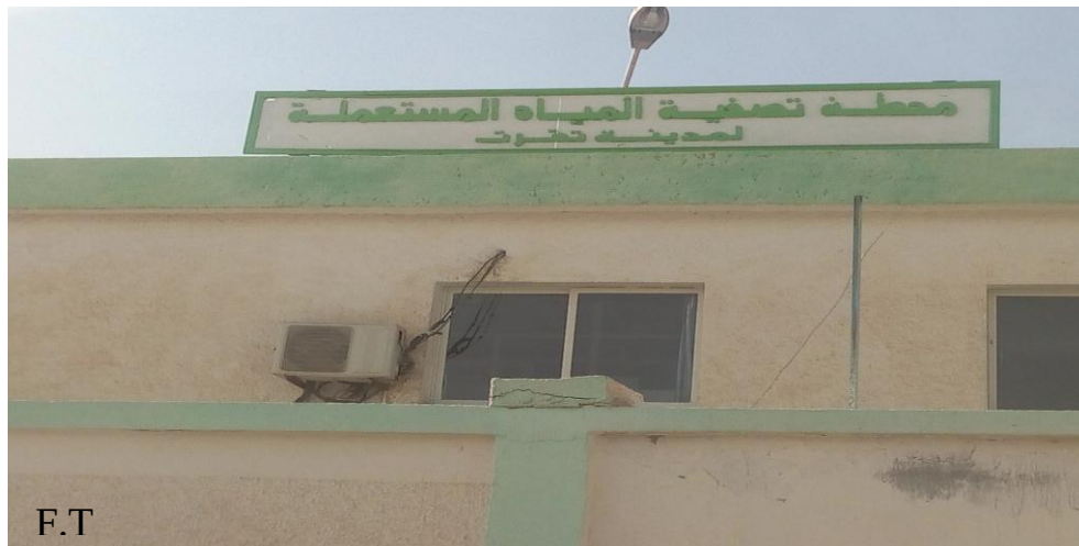
Photo.1 : photo de la station d'épuration de Touggourt.
