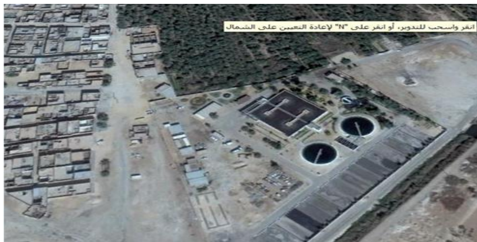
Fig.20 : Positionnement de la station d'épuration dans la commune de Tbesbest (google earth.fr, 2017).
