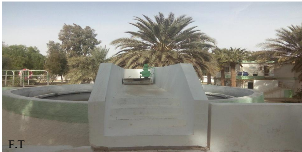
Photo.9 : Epaisseur de boues.
