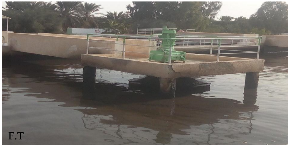
Photo.5 : Bassin d aération.
