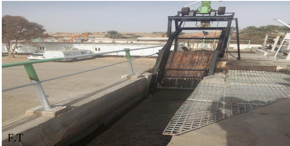
Photo.3 : Dégrilleur mécanique.
