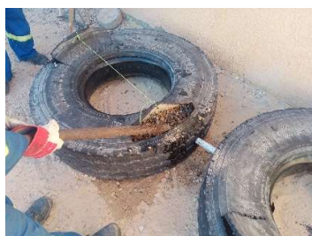
Remplissage de biomasse et mise en place du filtre en gravier gradué
