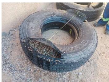
Remplissage de biomasse et mise en place du filtre en gravier gradué
