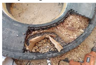
Remplissage de biomasse et mise en place du filtre en gravier gradué
