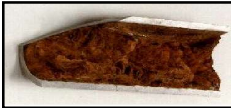
Figure I.8: Corrosion causé par bactérie.
