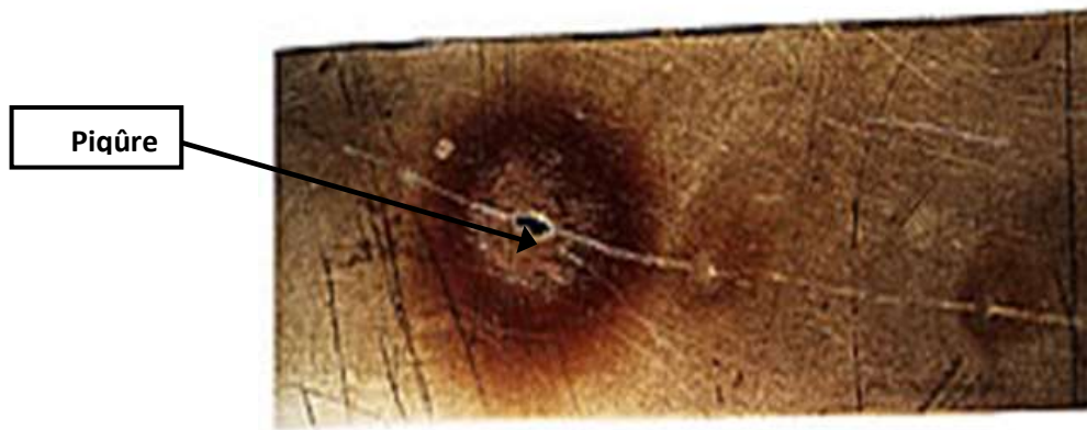
Figure I.5. Corrosion par piqûres d'une cuve en acier inoxydable.
