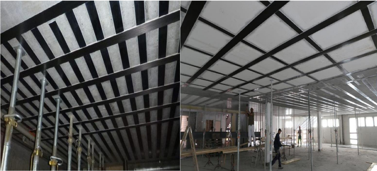
Figure 2.11: Renforcement des dalles en béton par des bandes en CFRP [13]
