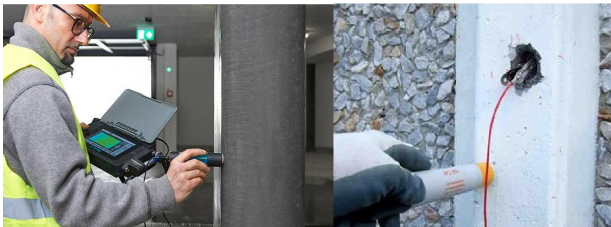
Figure 1.13: Mesure du potentiel de corrosion
