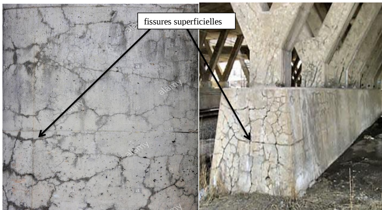
Figure 1.7. dans le béton causées par la décomposition alcaline
