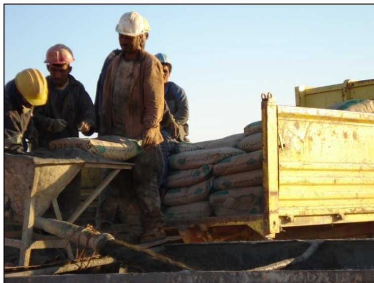
Figure III.6 : opération de cimentation
