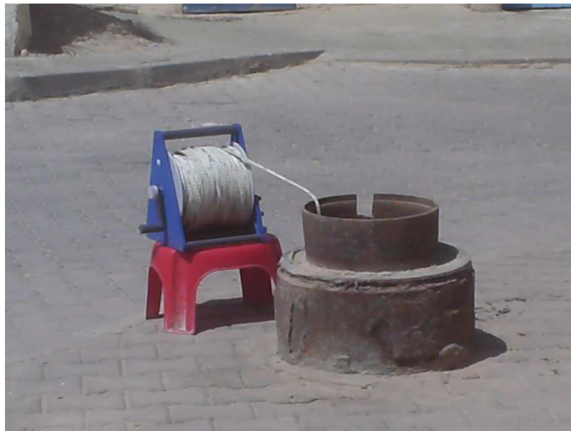
Figure IV.14 : la mesure par sonde piézométrique (forage)
