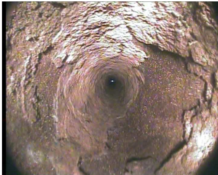
Figure IV.3 : Colonne de production
