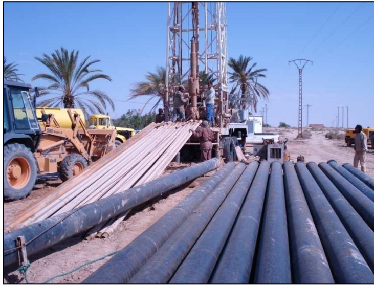
Figure III.5 : opération de tubage
