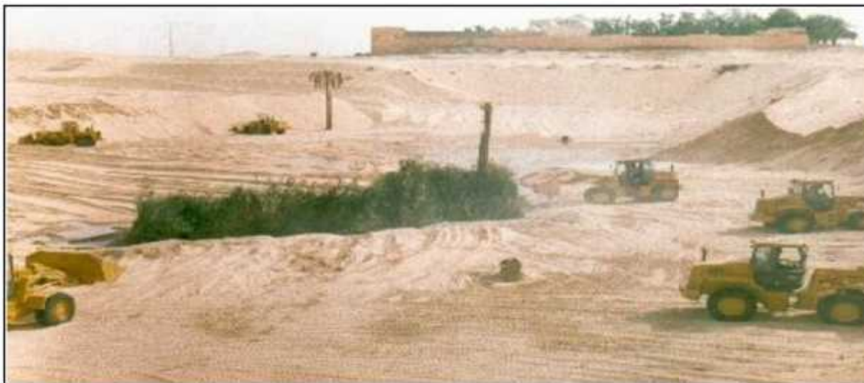
Photo. N°: (V. 05): Opération de remblaiement des Ghouts
