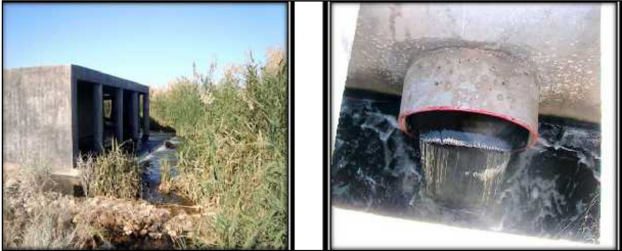
Photo. N°:(V. 08) : Exutoire canal de transfert
