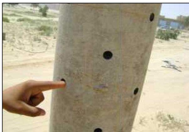
Photo. N°: (V. 02): Conduite d'amiante ciment utilisée dans le réseau drainage horizontale
