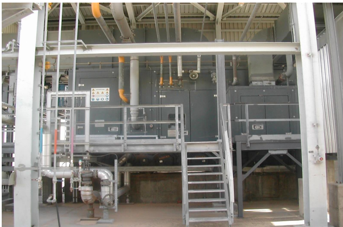
Figure II.11: vue générale de PGT10.
