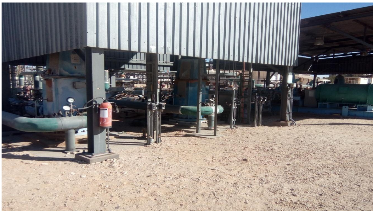
Figure II.9: Pompes d'expédition.
