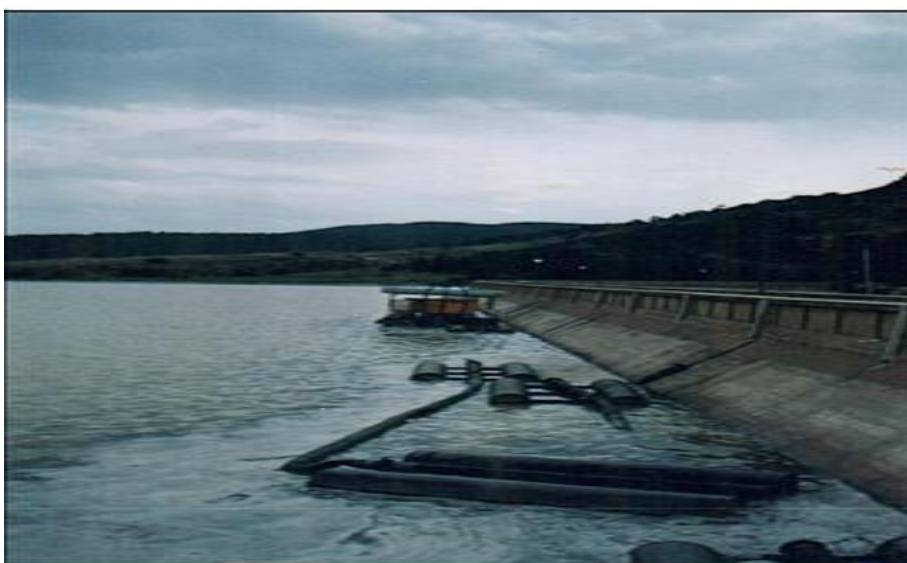
Figure I.12: L'envasement du Barrage de Foum El Guieiss (Tebbi, 2014)
