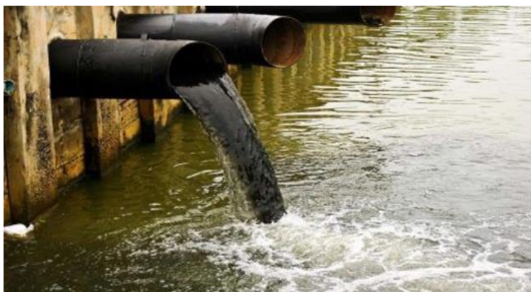
Figure 01 : Rejet des eaux usées industrielles (Genesis Water Technologies, 2023)
