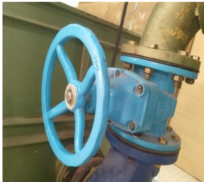
Figure 1.3: Photographie de La vanne de régulation du débit(Laboratoire Université Ouargla).
