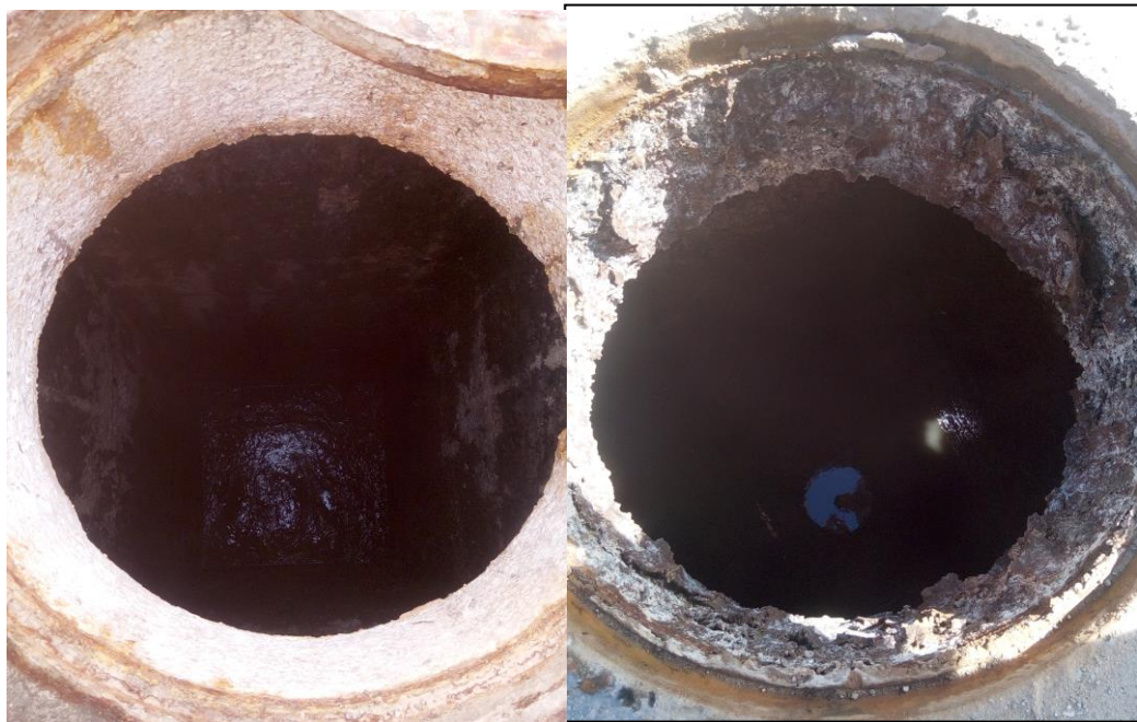
Photo II-3 : type des regards en état de service
