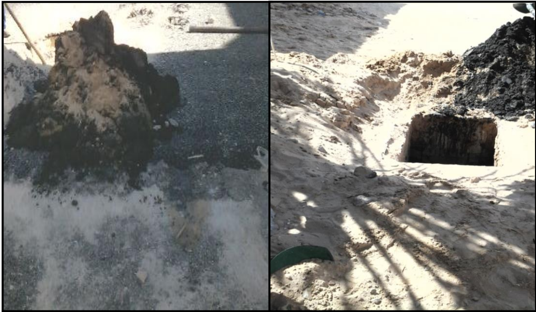
Photo II-2 : nettoyage de regard ( dessablement)
