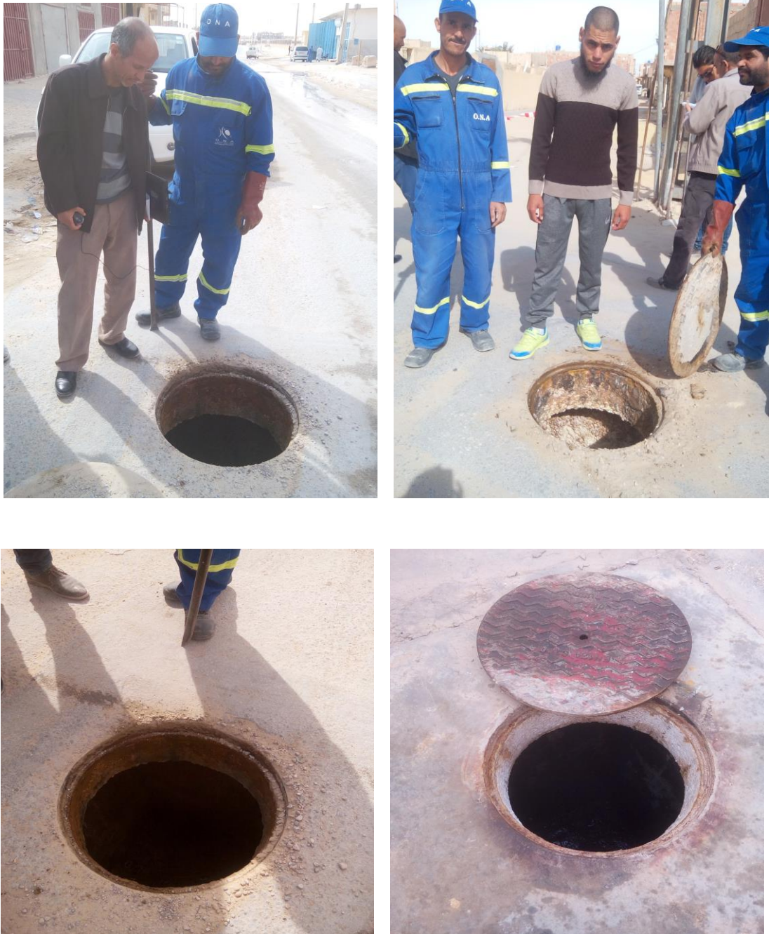
Photo II-1 type des regards en bon état
